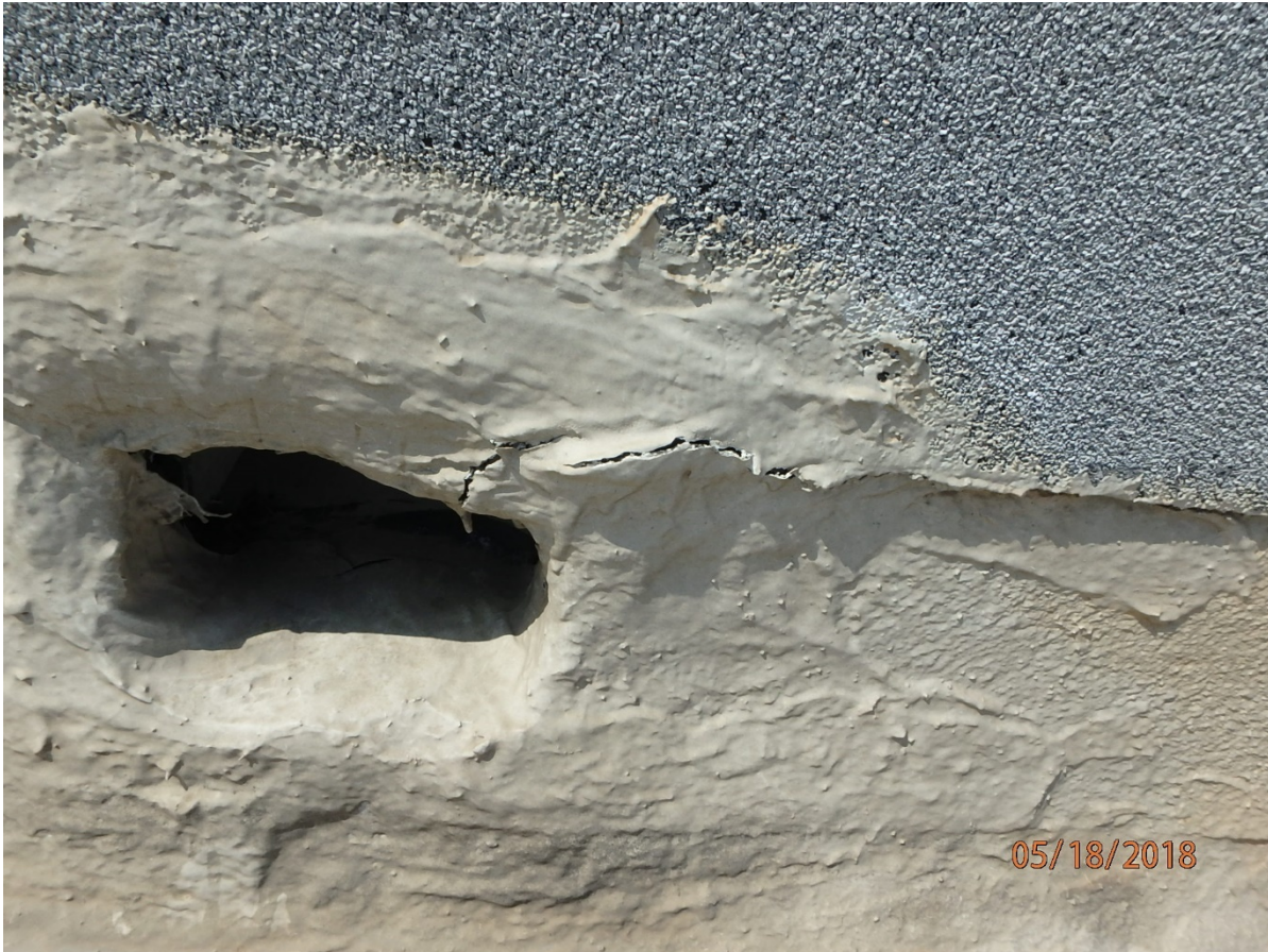
Repair per NRCA guide lines
